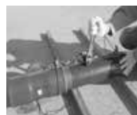
④ パイプと継手の接着
