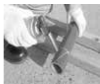
② FRP層の加熱剥離
