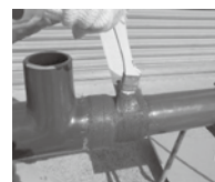
⑥ 接合部のFRP補強
