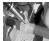
⑤ 接合部の塩ビ溶接
