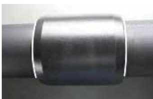
管をEF継手の奥まで挿入し、挿入標線を再度記入します。
