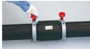
EF継手が管全周の挿入標線までしっかり挿入されていることを確認後、専用クランプで固定します。
