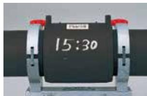
インジケーターが左右とも継手表面より隆起していることを確認し、(250A以下)、更に、継手受口部の管にスクレープ余長があることを確認した後、冷却終了時刻と施工者名を継手表面にペン等で記入してください。
