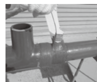
⑥ 接合部のFRP補強
